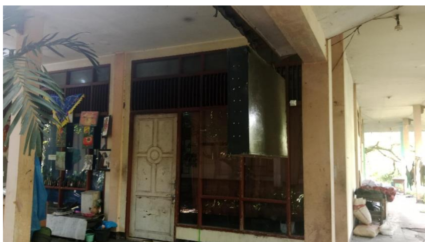
d. Tampak Sebalah Kiri Ruangan
