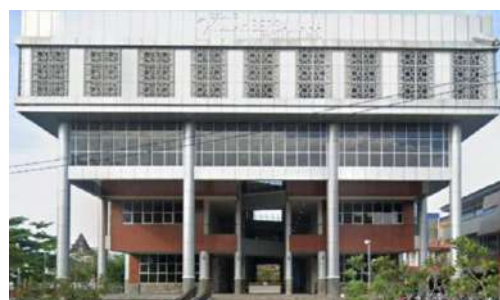
Gedung Kuliah Bersama A Tampak depan
