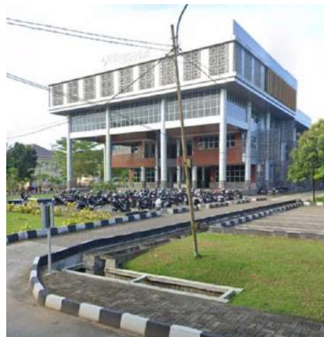
Foto Gedung Kuliah Bersama A Tampak kiri
