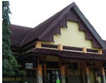
Gedung FMIPA UNTAN
