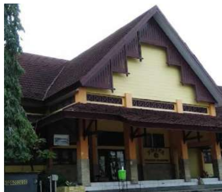
Gedung FMIPA UNTAN
